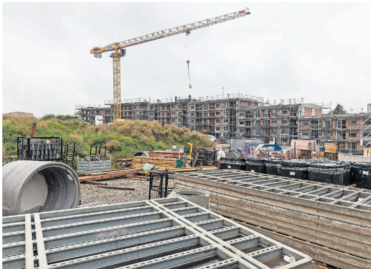
Bei den Gebäuden ist der Fortschritt gut sichtbar. Aber auch die Planung der zusätzlichen Nutzungen nimmt Gestalt an.
